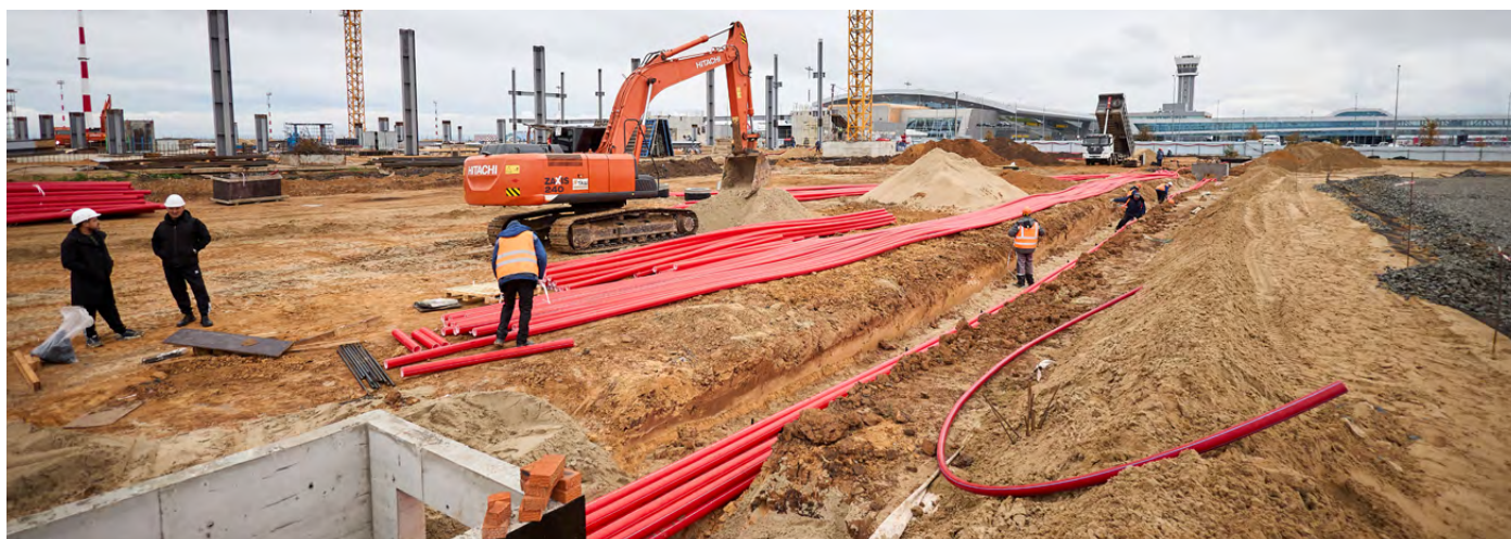
Прокладка труб «Электроплекс» при строительстве нового терминала казанского аэропорта
